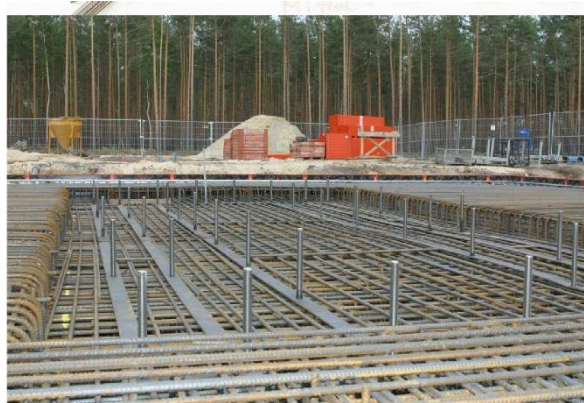
شکل ۲۴: آرماتوربندی خاص استفاده شده در بتن مسلح به عمق ۵ متر و بولت های موجود در بالای قسمت بتنی برای اتصال صفحه ی فولادی
