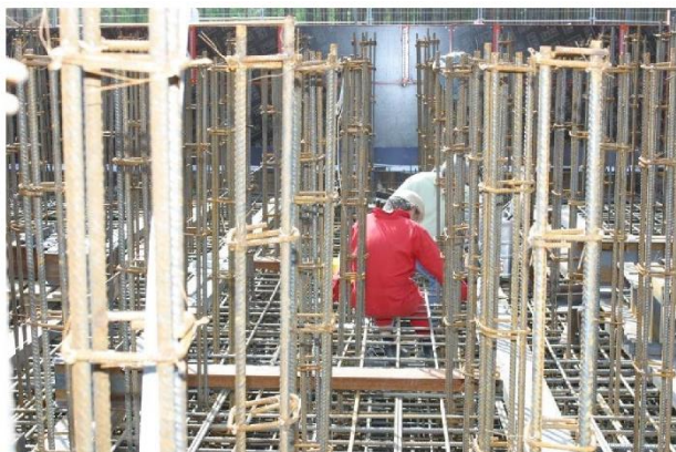
شکل ۲۴: آرماتوربندی خاص استفاده شده در بتن مسلح به عمق ۵ متر و بولت های موجود در بالای قسمت بتنی برای اتصال صفحه ی فولادی
