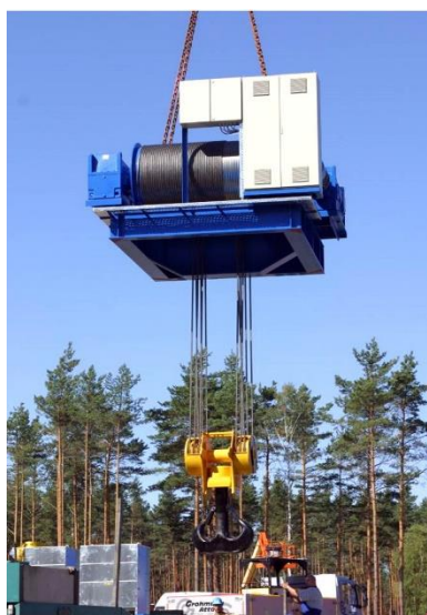
شکل ۸: انتقال هویست ۲۰۰ تنی به بالای برج
