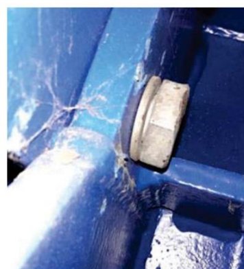
شکل ۲۵: اتصالات در سازه برج (شکل چپ)، شل شدن پیچ در اتصال (شکل راست)
