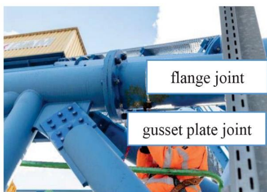
شکل ۲۵: اتصالات در سازه برج (شکل چپ)، شل شدن پیچ در اتصال (شکل راست)
