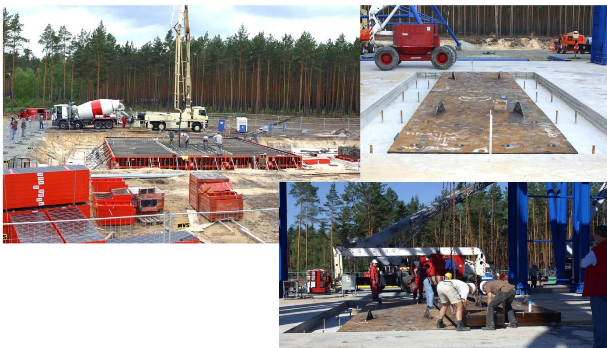
شکل ۱۹: بخشی از مراحل اجرای صفحه برخورد برج سقوط بزم
