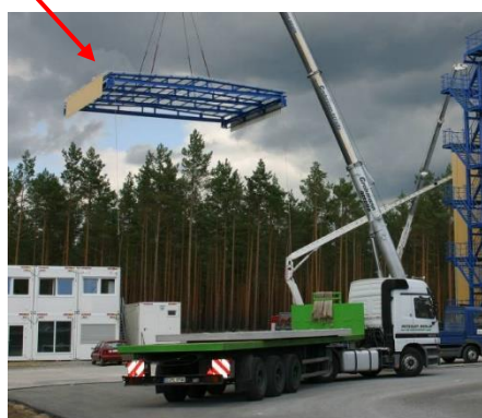
شکل ۴: درب متحرک بر روی سقف سالن تست
