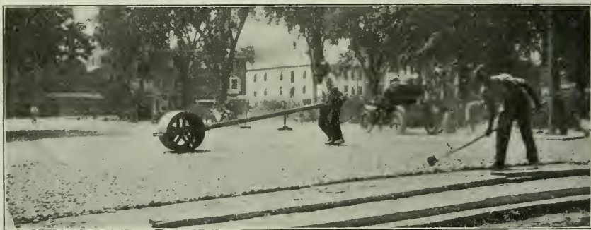
LAYING BITUCRETE IN MORRISTOWN, N. J.
