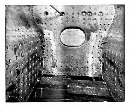
FIG. 2. WELDED FIRE-BOX.
