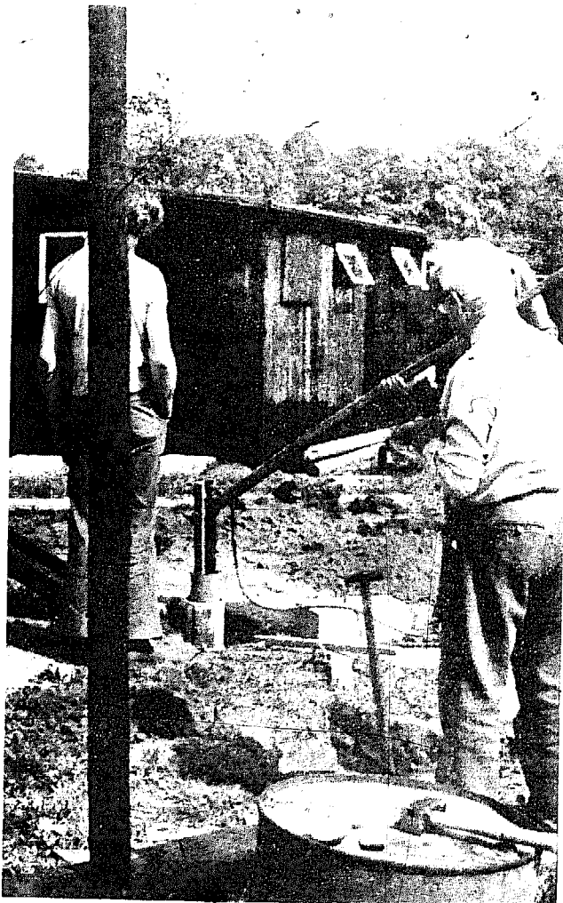
het gebruik van de puls auger in operating
