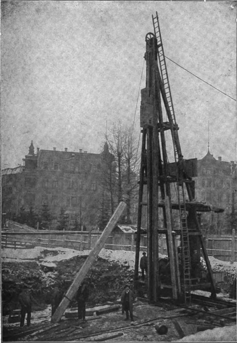
FIG. 268.—Station in Cannstatt. Hoisting piles.
