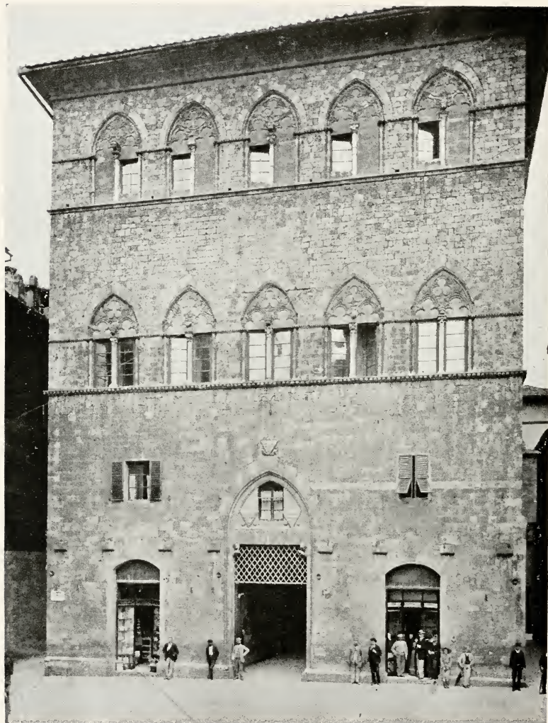
FAÇADE Palazzo Tolomei, Siena
