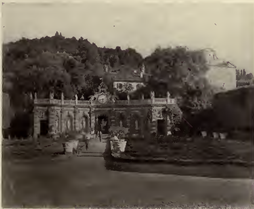
Villa Lancellotti, Frascati. A glorified retaining wall.
