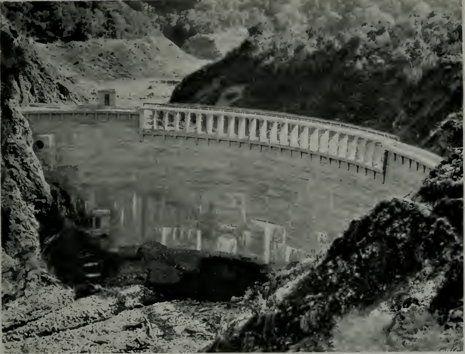
SAN CLEMENTE DAM, MONTEREY J. A. Wilcox, C. E.
