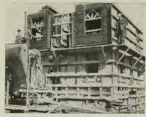
HOUSE IS CAST IN ONE CONTINUOUS OPERATION, FORMS BEING SET UP COMPLETE BEFORE CON-CRETE IS POURED
