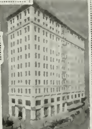
HAAS BLDG. LOS ANGELES, CAL.
