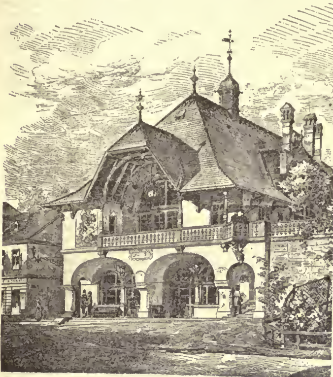
Restaurant at Dornbach, Austria. From Architektonische Rundschau.
