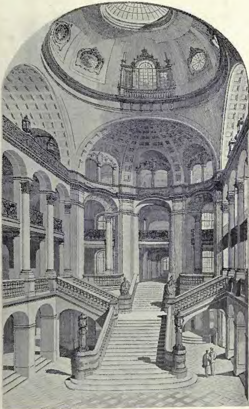
1292. Oberlandesgericht in Köln, Treppenhaus, Oberleitung: WIRKLICHER GEH. OBER-BAURAT THOEMER, Architekt.
