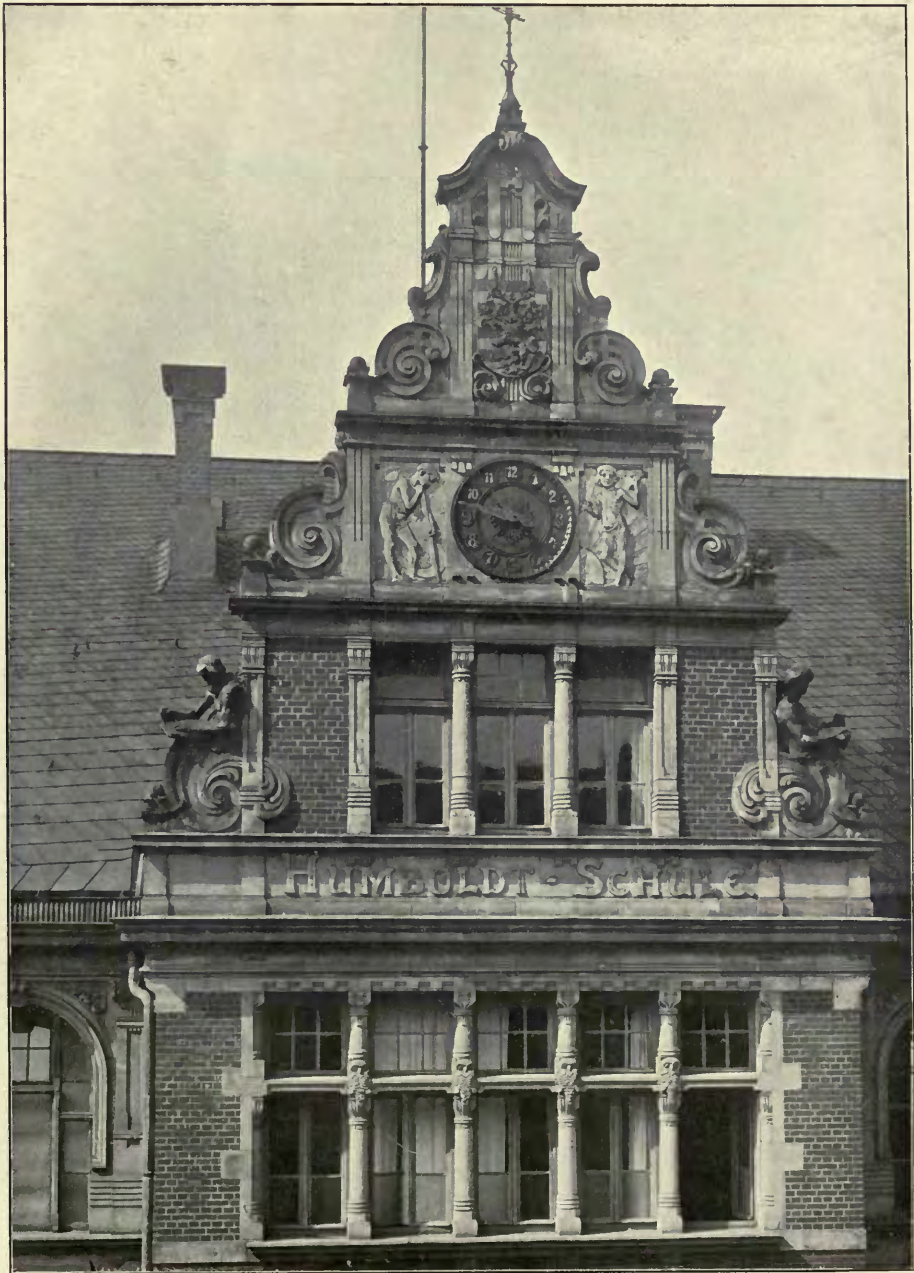
Humboldt-Schule, Hannover-Linden, ALFRED SASSE, Architekt.
