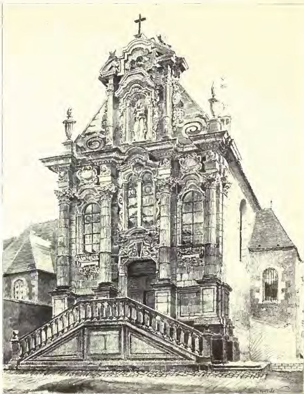
3913. La Chapelle de l'Ancien Couvent de la Visitation, Avoyers, L. J. G. MOHLER, Architecte.
