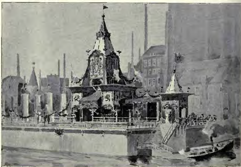
Le Pavillon pour l'Empereur dans les usines Ballik à St. Petersburg, ST. GALENZOVSKY et A. J. JOLTOVSKY, Architects.
