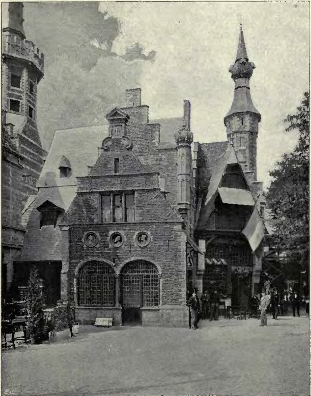
Exposition internationale de Bruxelles, 1897, Concours pour le "Vieux Bruxelles," 1 er Prix, ÉMILE LAMBOT, Architect, Lacken, Bruxelles.
