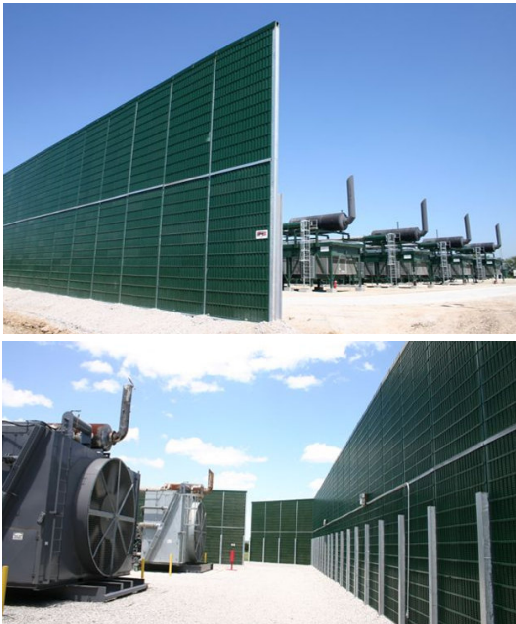
Figura 3. Típico control de ruidos en equipos compresores de aire y/o gas mediante barreras fonoabsorbentes.
