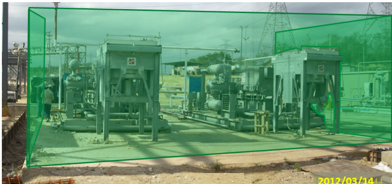
Figura 4. Vista de la ubicación de los equipos con un montaje aproximado del arreglo fonoabsorbente planteado.
