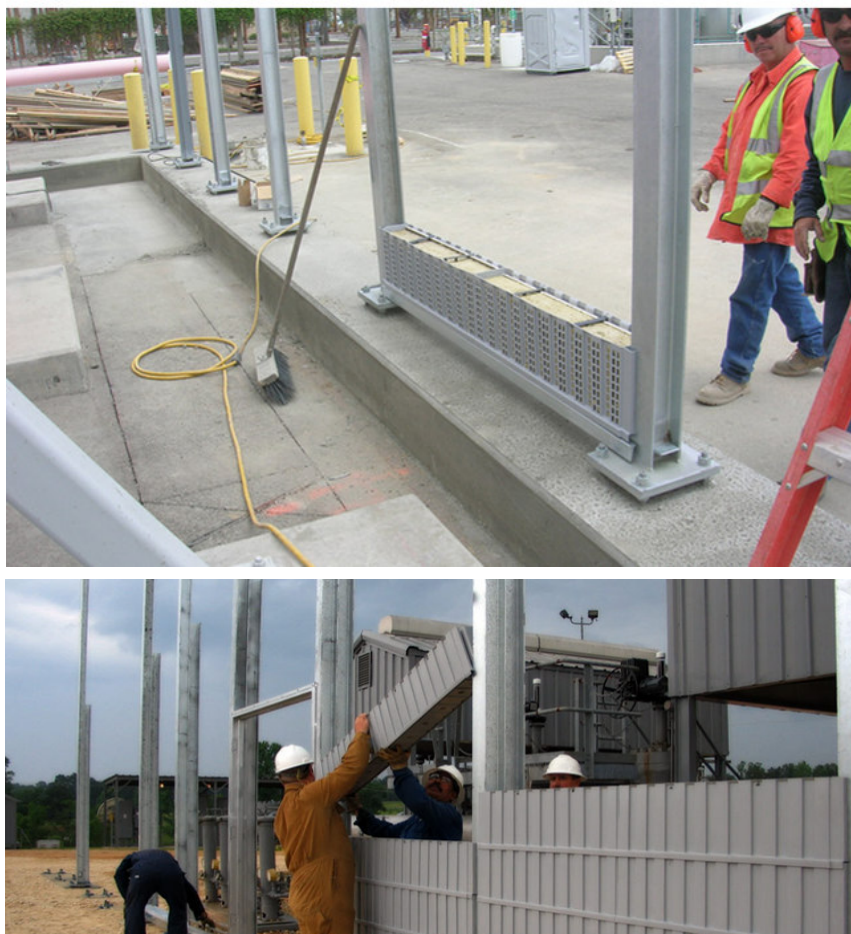
Figura 8. Fácil y rápida instalación de paneles en una construcción de barrera típica.
