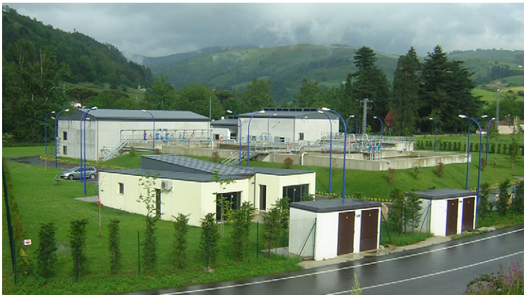
FIG. 5.17 The Arenas de Iguña site.
