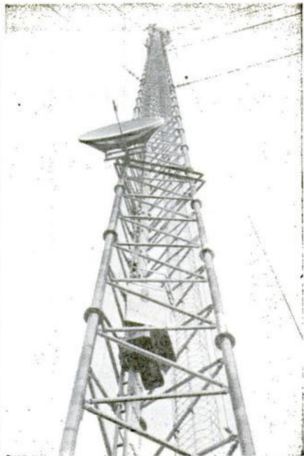
Alimak Verken A.B., Skelleftea, Sweden
