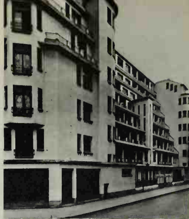
856. FRANCE. HENRI SAUVAGE (1873–1932). Block of flats in glazed brick, rue des Amiraux, Paris. 1925.
