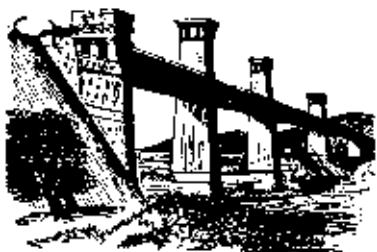
Tubular Bridge 5430R-ME
