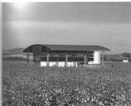
Edificio para báscula y control de vendimia en las bodegas Torres, Pacs 1993
