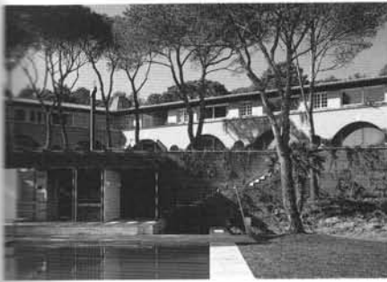
Vivienda unifamiliar, S'Agaró 1992
