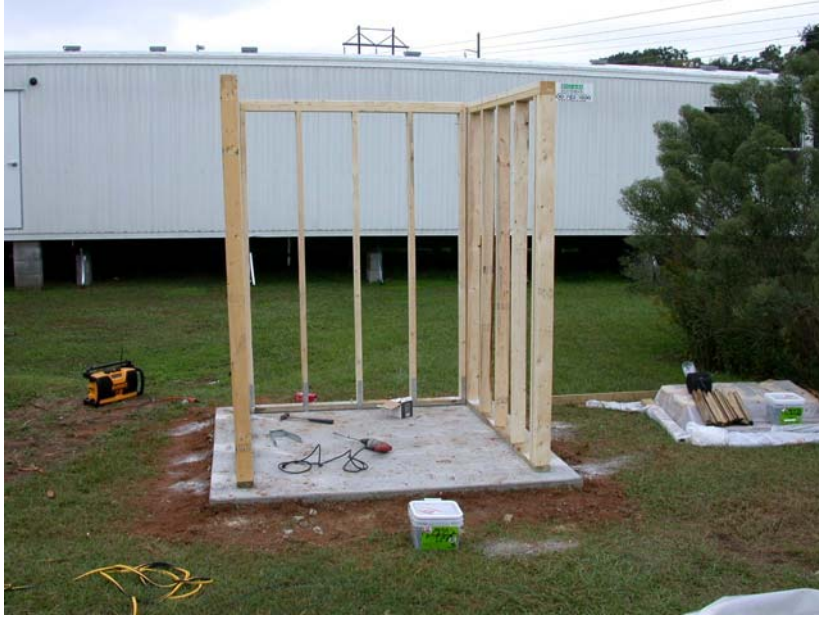
Stud Wall Construction
