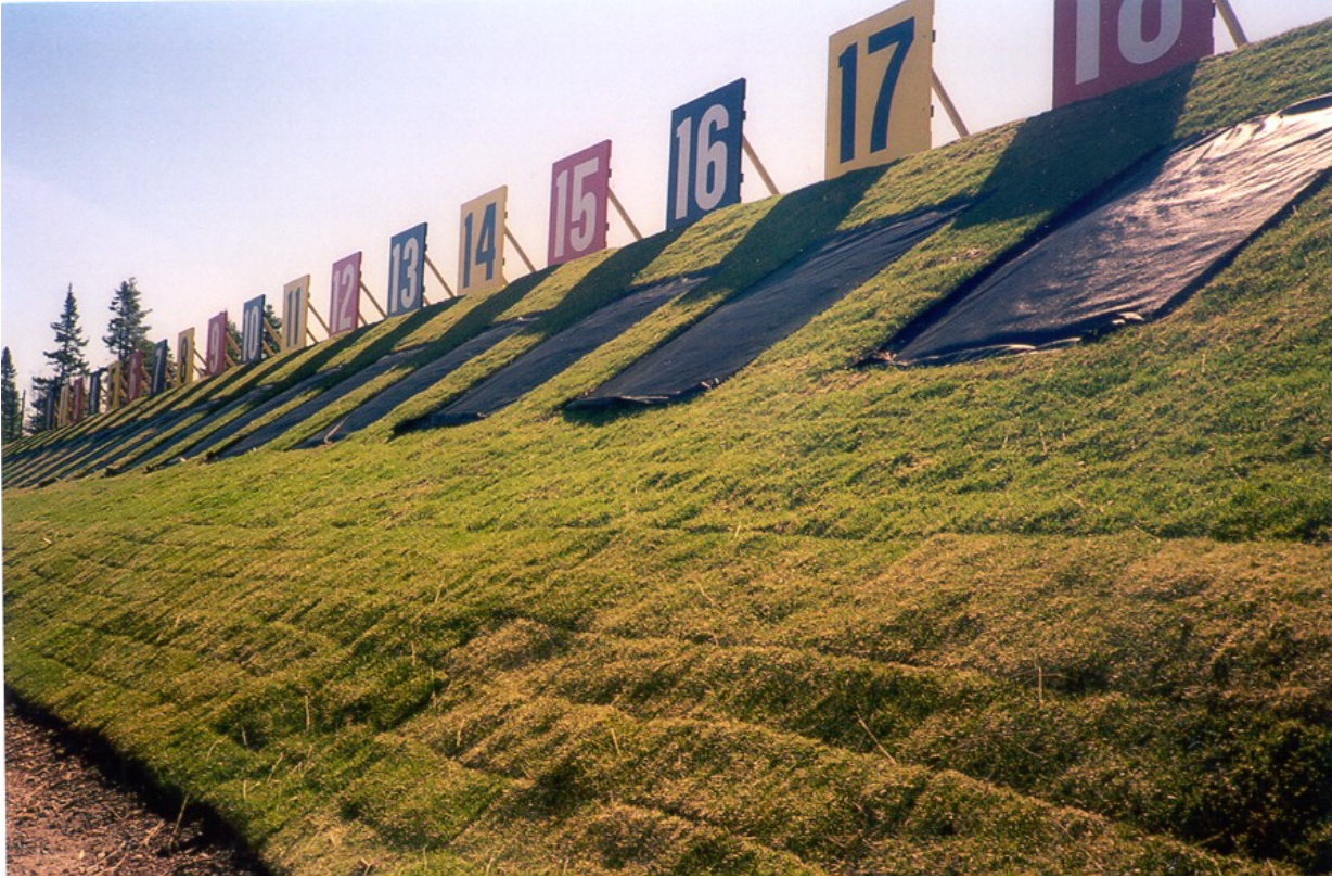
Standard Classification Range/ Champ de tir de classification standard 34 ° Slope of the Backstop/ Butte d'arrêt de 34 ° degrés de pente
