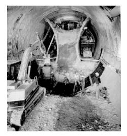
Fig. 4.8. Sidewall drift<sup>4</sup>
