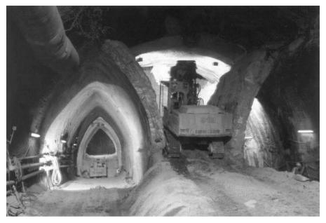
Fig. 4.10. Niedernhausen tunnel, sidewall drift<sup>5</sup>
